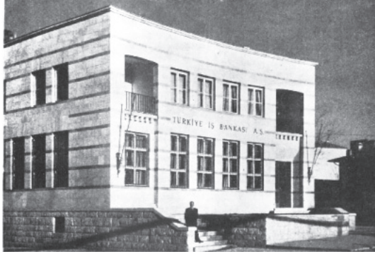
Yüksek Mimar Mühendis Arif Hikmet Holtay tarafından inşa edilen Malatya İş Bankası Binası (Arkitekt, s. 5).
