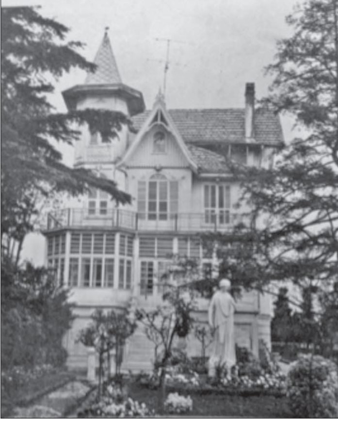
Kadıköy Fenerbahçe’de 1978 yılında yıkılan Viktoryen tarzda bir köşk (Balcı, 1980, s. 30).
