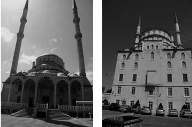
Florya Yeni Camii'nin ön (soldaki) ve arka (sağdaki) cephelerinin uyumsuzluğu. Arka cephe görünümünde, yapının üzerine kubbe kondurulması apartman izlenimini ortadan kaldırmamaktadır.
