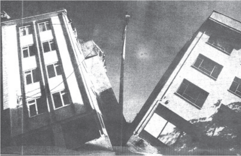
Konstrüksiyon hatalarından ortaya çıkan yıkımlar
